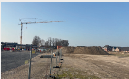
Foto ©Stadt Vreden, Gelände Weberhöfe
